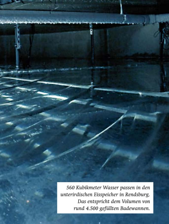
560 Kubikmeter Wasser passen in den unterirdischen Eisspeicher in Rendsburg. Das entspricht dem Volumen von rund 4.500 gefüllten Badewannen.
